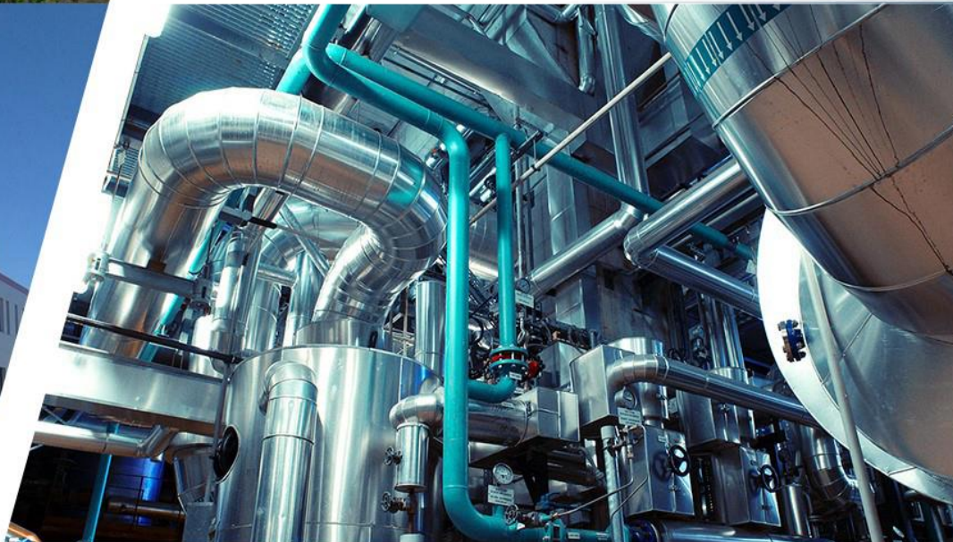
AUTOMATYKA I ELEKTROTECHNIKA
